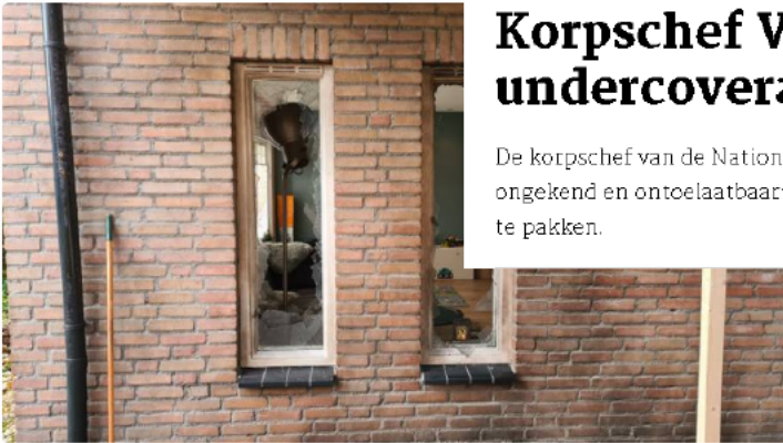
Bij daglicht is de schade goed te zien (foto: Noël van Hoof)
